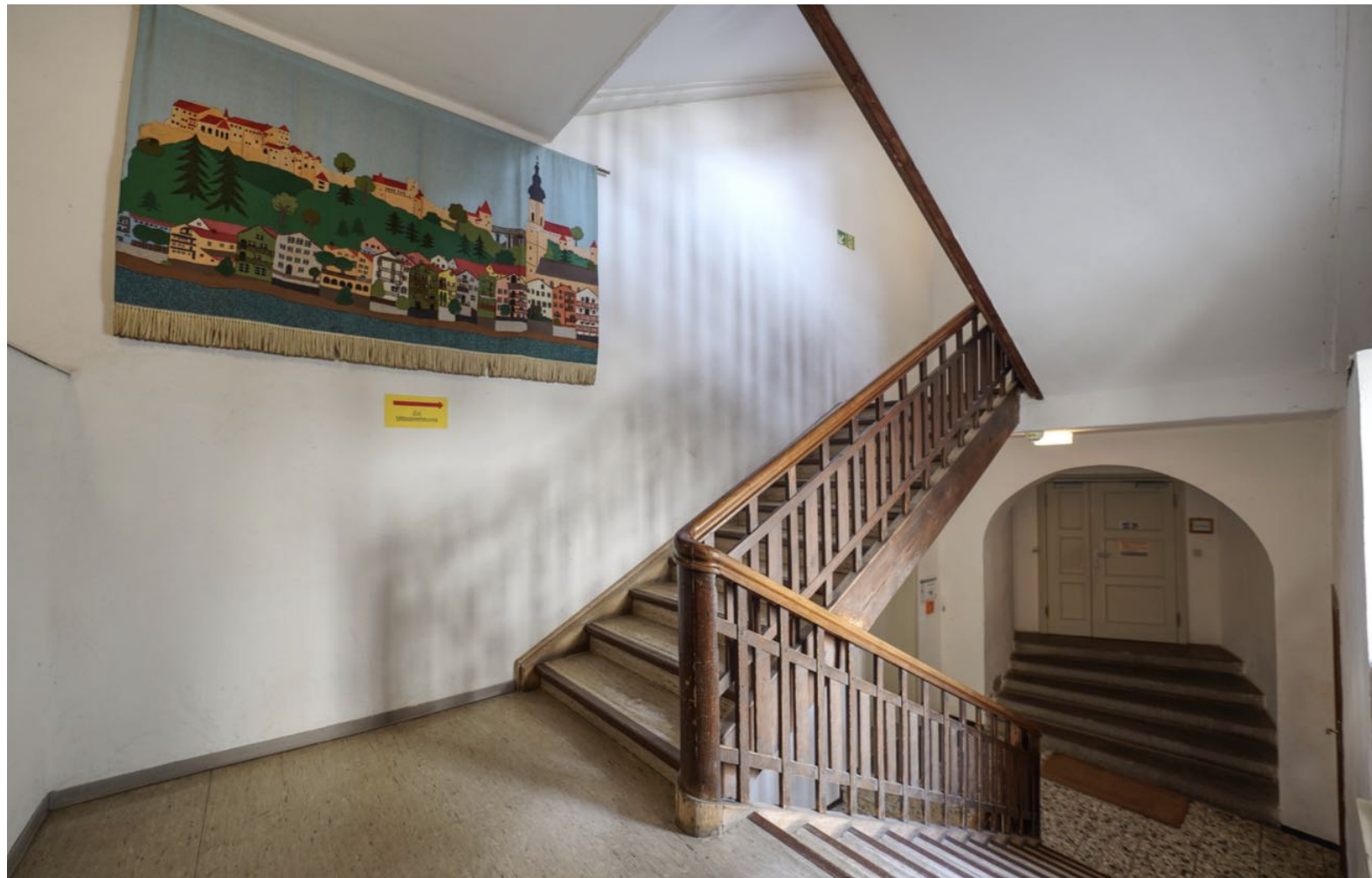
Treppe 7 - Blick vom Zwischenpodest EG / 1.OG
